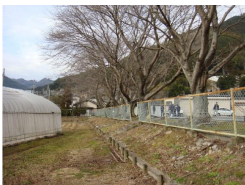
ビニールハウス側 作業前
